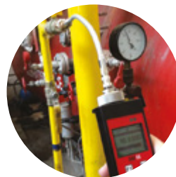
Režim pre asistenciu pri odvzdušňovaní plynovodov
